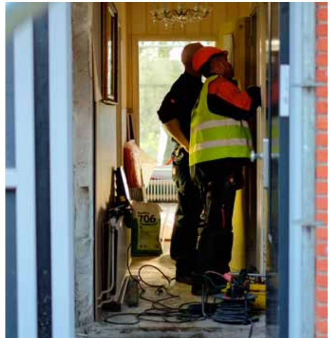
DE MANNEN AAN HET WERK, TERWIJL HET HUIS NOG BEWOOND IS
