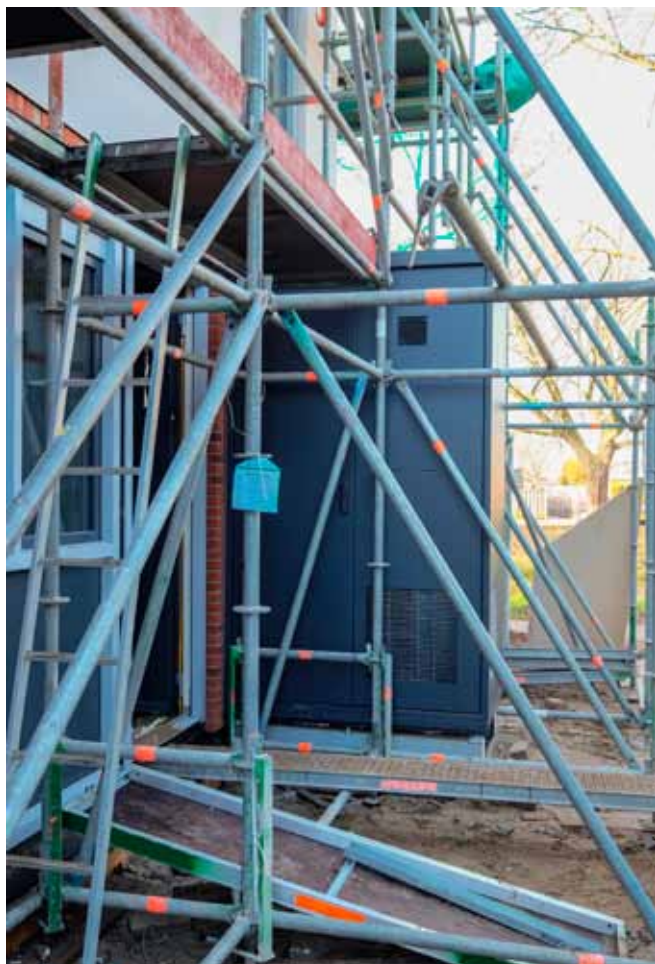
NATHAN ENERGIEMODULE GEPLAATST VOOR HET EERSTE HUIS
